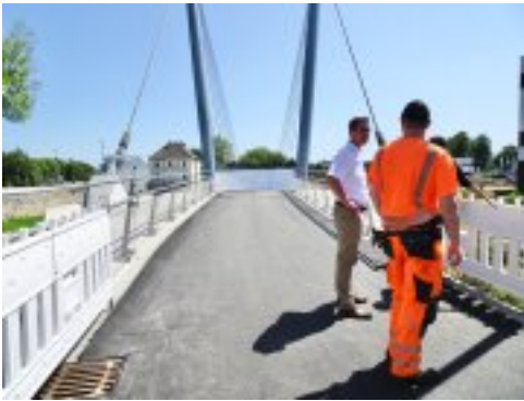
Die Ruhe vor dem Sturm: Tiefbauamtsleiter Raatz gibt letzte Anweisungen...
