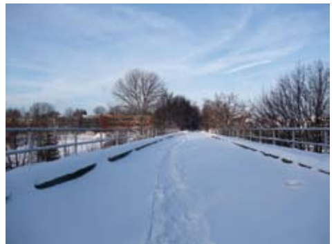
Eisenbahnbrücke im Schnee
