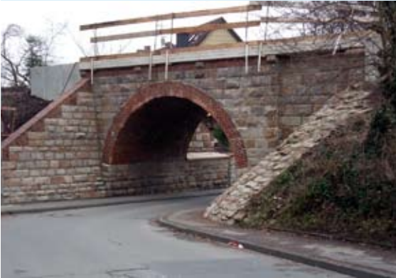
Das Foto zeigt die frisch geputzte Brücke am Ledderken
