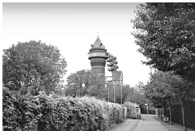
Ehem. Wasserturm Aquarius in Mühlheim
