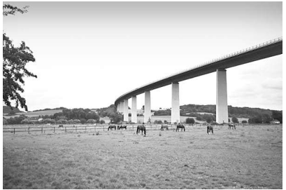
Ruhrtalbrücke bei Mühlheim-Mintard
